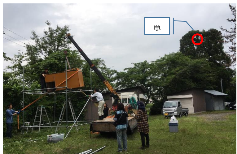
写真③ ハックボックスの設置
